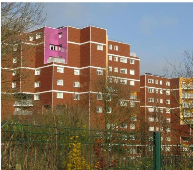
*Isolation des murs, toitures, remplacements des menuiseries... les 3 blocs d'immeubles du bailleur PARTENORD sont devenus bien moins énergivores en passant de l'étiquette C ou D à l'étiquette B*
