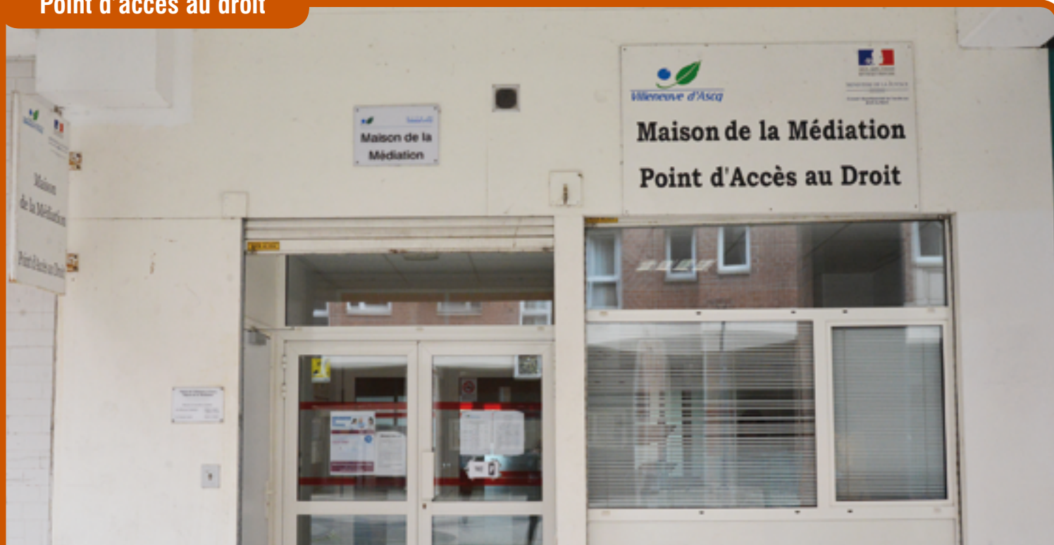
Le Point d'Accès au Droit, chaussée de l'Hôtel-de-Ville
