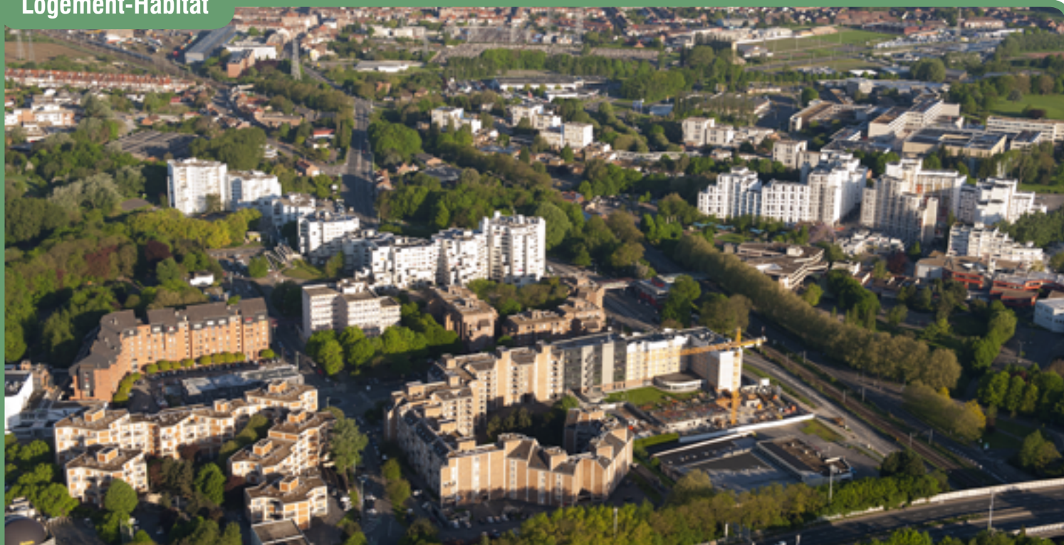
Quartiers Hôtel-de-Ville et Pont-de-Bois
