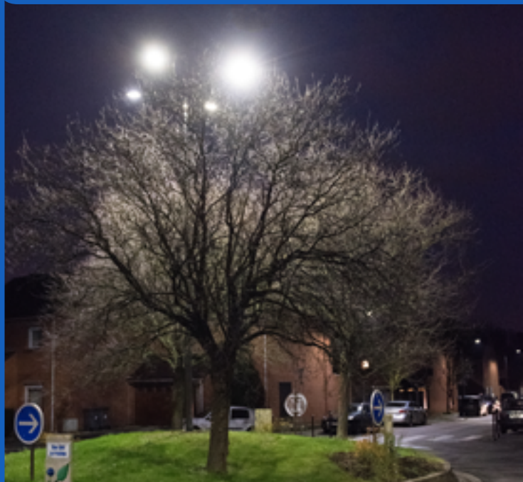
Nouvel éclairage public dans le quartier des Prés
