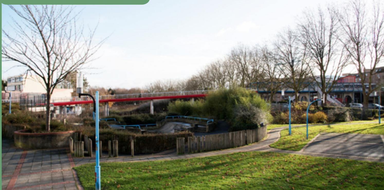
Nouvelle passerelle du Pont-de-Bois
