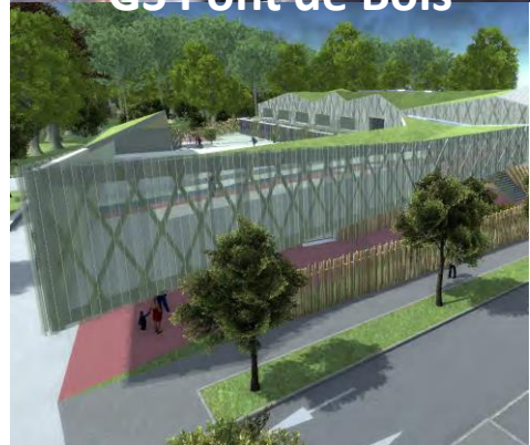
GS Pont de Bois
