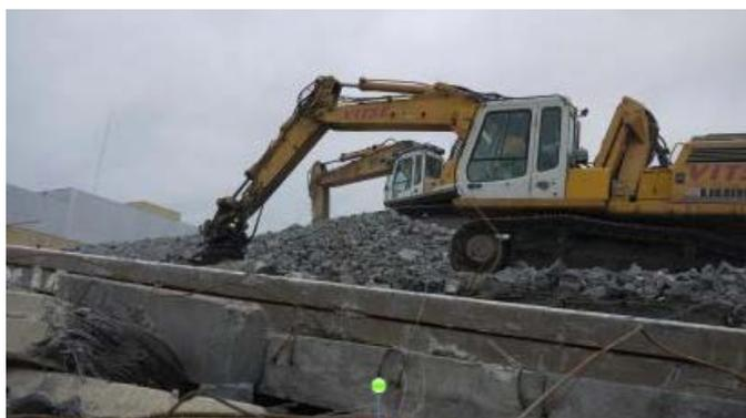
**Objectif zéro déchet.** Les 30 000 tonnes de béton à démolir seront recyclés selon un processus totalement nouveau mis sur pied en collaboration avec l'école des Mines de Douai. En amont, 10 000 m<sup>2</sup> de parquet en chêne, 4 500 luminaires, plusieurs tonnes de pièces de métal (notamment des rayonnages) seront prélevées en vue d'un réemploi.
