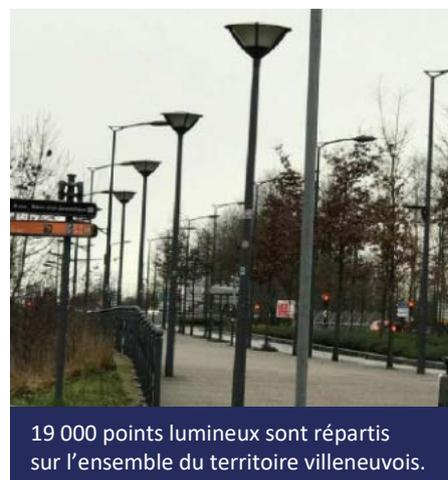
Déploiement de la gradation de l'éclairage public : cela consiste en l'adaptation de l'éclairage d'un espace, d'une voirie, d'un cheminement en fonction de sa fréquentation. La puissance de l'éclairage est ainsi réduite en fonction de plages horaires ou/et détection de présence.
