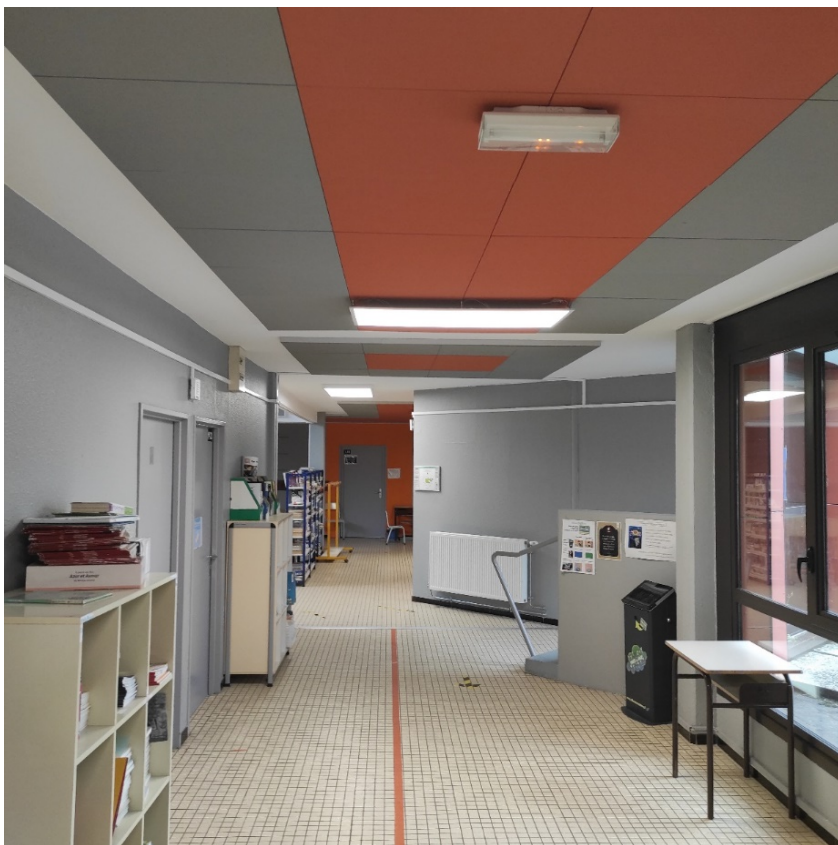
GROUPE SCOLAIRE VERHAEREN Doublement des classes, création d'une salle des maîtres, travaux d'amélioration acoustique
