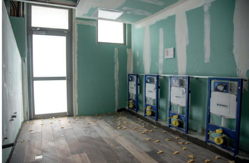
riaux existants (cloisons, faïences, carrelages, menuiseries intérieures, installations électriques, ventilation...) ont été déposés, puis remplacés, les sanitaires rendus accessibles PMR. Des plafonds acoustiques ont été posés pour améliorer le confort acoustique, les menuiseries intérieures des sanitaires, les installations électriques, les peintures et les éclairages rénovés eux aussi. L'agencement des locaux intègre des zones de rangements et différentes ambiances aux couleurs chatoyantes.
