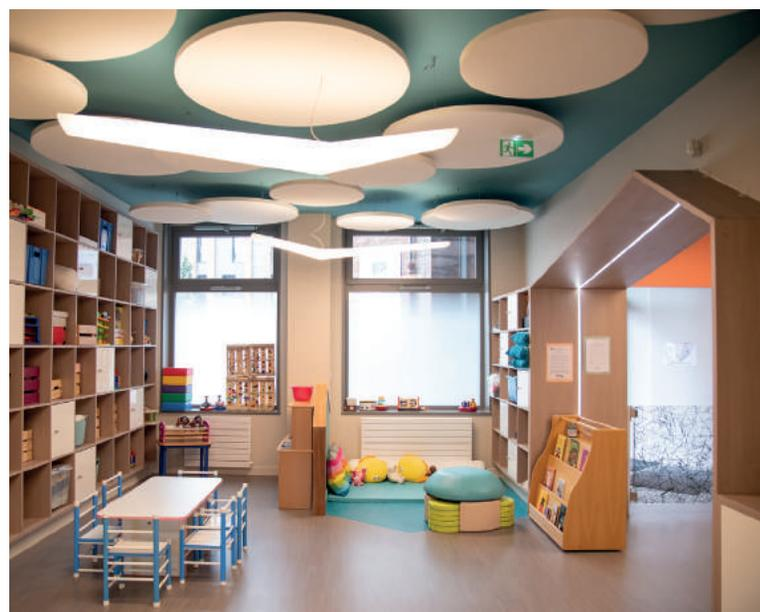
l'installation de baffles acoustiques. Les distributions et appareillages électriques, informatiques, de plomberie et de chauffage ont été remplacés.
