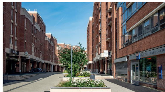
La chaussée de l'Hôtel de Ville
