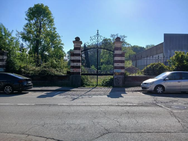
Portail d'entrée rue Jean Jaurès
