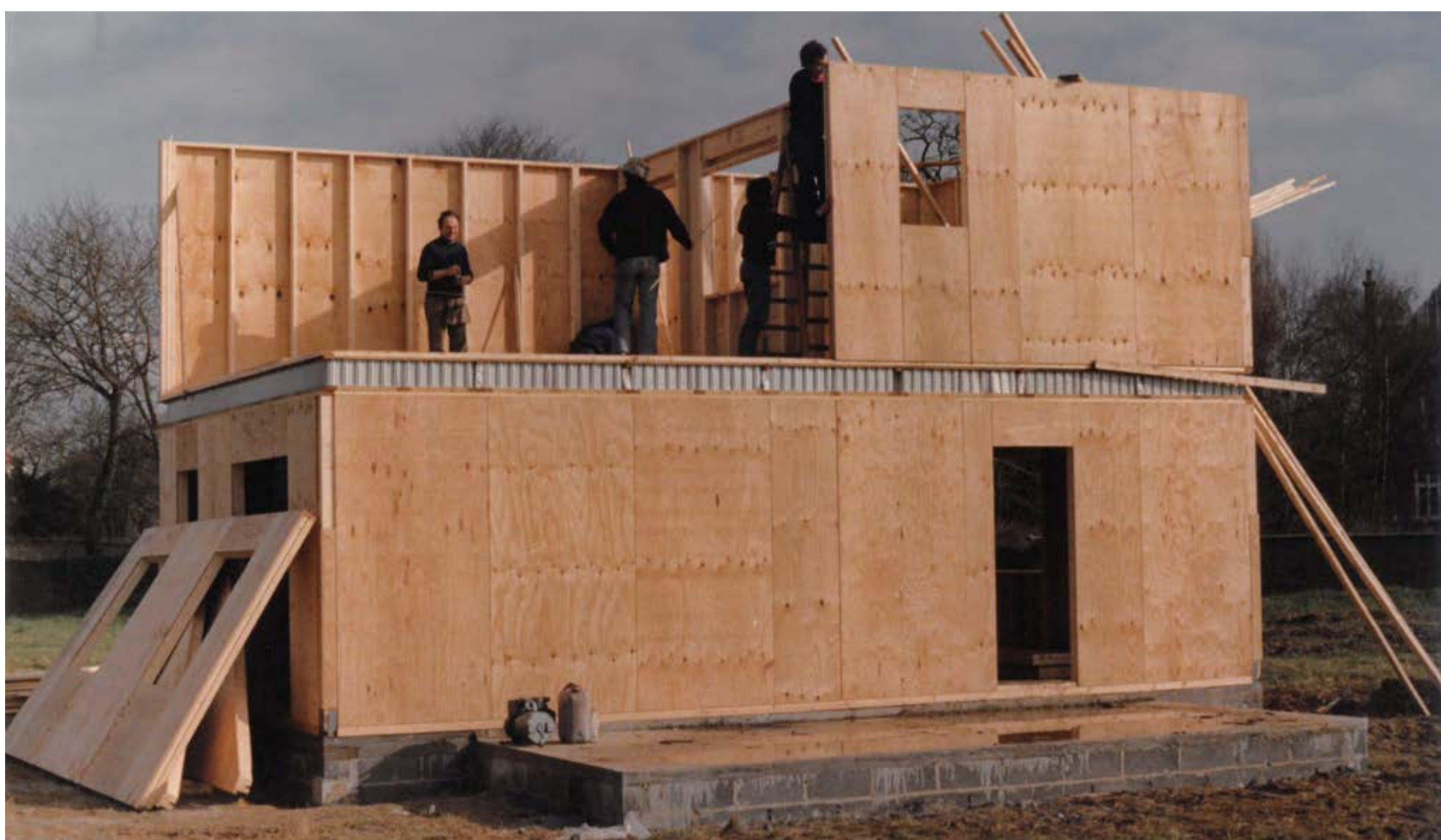
Maison en cours de montage
