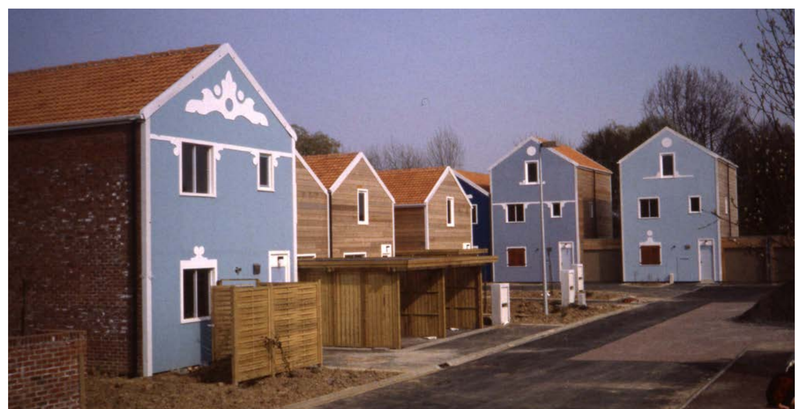
Maisons en cours de finition début 1982
