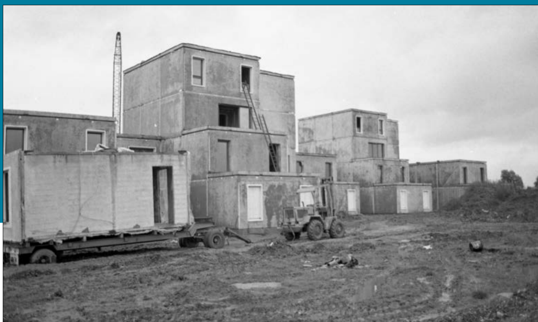
Les Courtilles, un module arrive sur le chantier, 1975 Archives municipales de Villeneuve-d'Ascq, fonds EPALE, 7Fi2926
