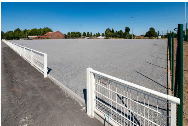
La stade Beaucamp pendant les travaux
