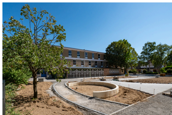
Cour des CM1 / CM2 pendant les travaux
