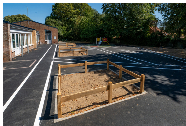
Cour de l'école maternelle pendant les travaux
