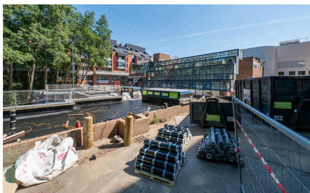
Le chemin des visiteurs pendant les travaux
