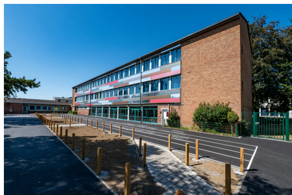
Cour de l'école élémentaire pendant les travaux
