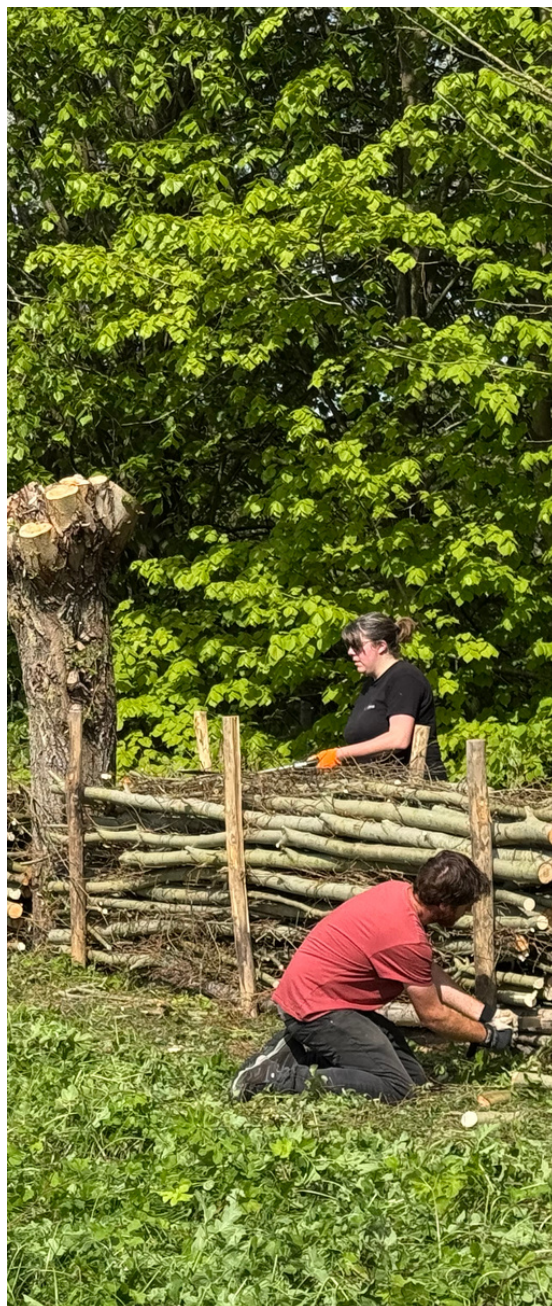
Création d'une haie sèche
